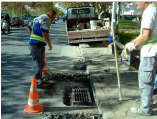
Construção/substituição de sumidouros na Av. Dr. Francisco Sá Carneiro.
