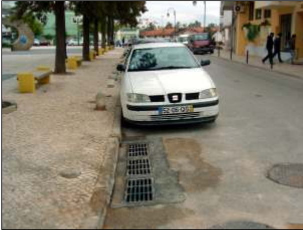
Construção/substituição de sumidouros no Largo Gil Eanes.
