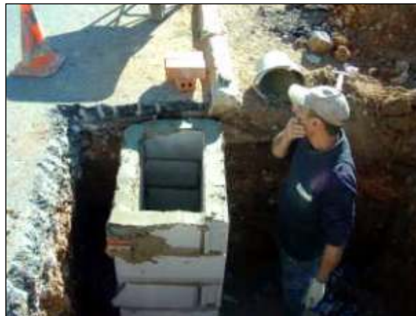
Construção/reparação de sumidouros na Urb. Xavier de Lima/Rua Mouzinho de Albuquerque.
