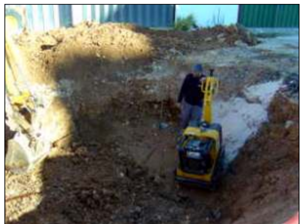
Desobstrução de linha de água e reparação de coletor pluvial DN 600mm, na Pedra Mourinha, junto à Mercedes.
