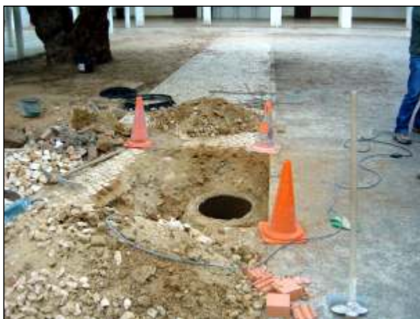
Ligação de pluvial e construção de caixa de visita na Escola Primária nº 1, da Estrada de Alvor.
