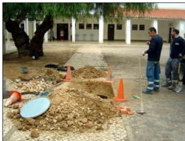
Ligação de pluvial e construção de caixa de visita na Escola Primária nº 1, da Estrada de Alvor.
