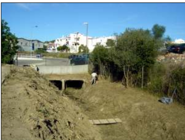
Desobstrução de linha de água e reparação de coletor pluvial DN 600mm, na Pedra Mourinha, junto à Mercedes.
