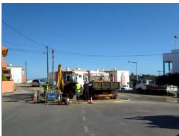
Substituição de válvulas DN 250 mm, na Urb. Jobevi.
