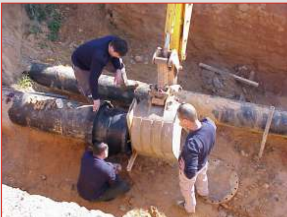
Trabalhos de interligação da conduta DN 500, na Estrada de Monchique
