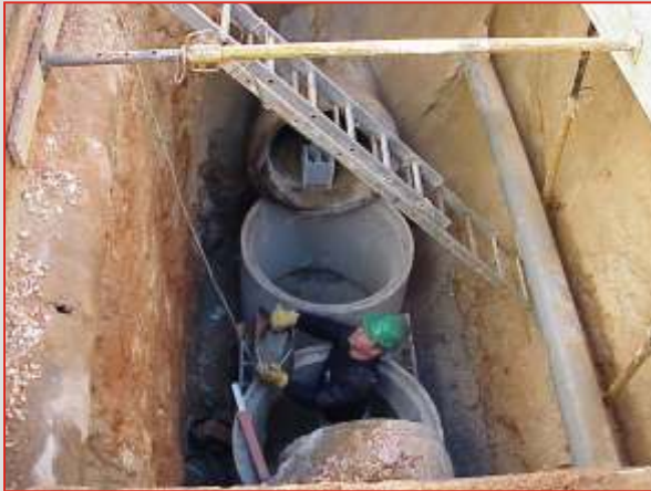
Execução da caixa de sifonagem do descarregador de tempestada, na Rua Frei Miguel do Sepulcro
