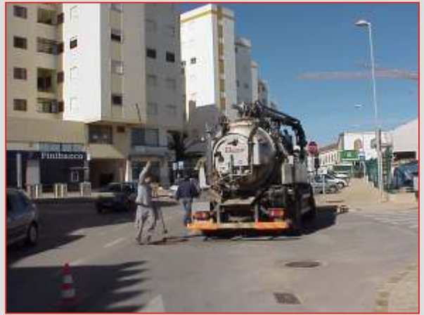
Desentupimento de um colector de esgoto na curva do Convento
