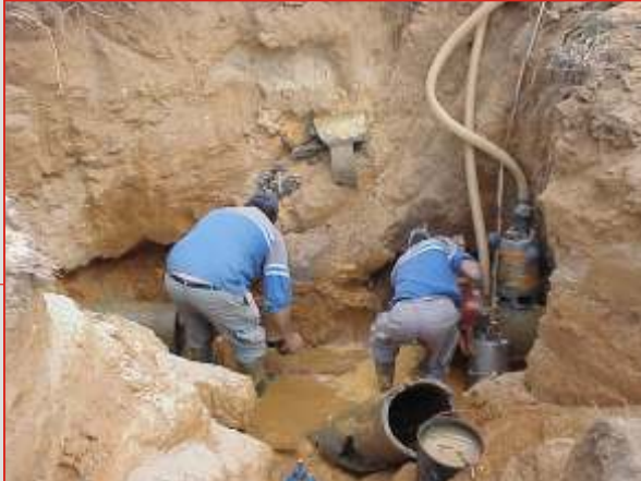
Reparação de rotura na conduta de água DN 315 mm, em Alvor
