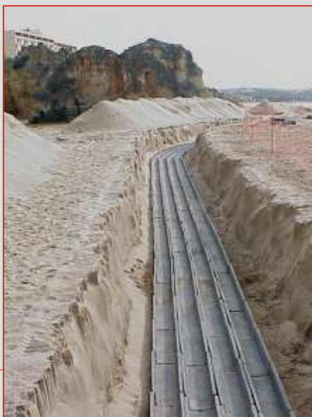
Caleiras técnicas para instalação das infra-estruturas da obra dos arranjos da Praia da Rocha
