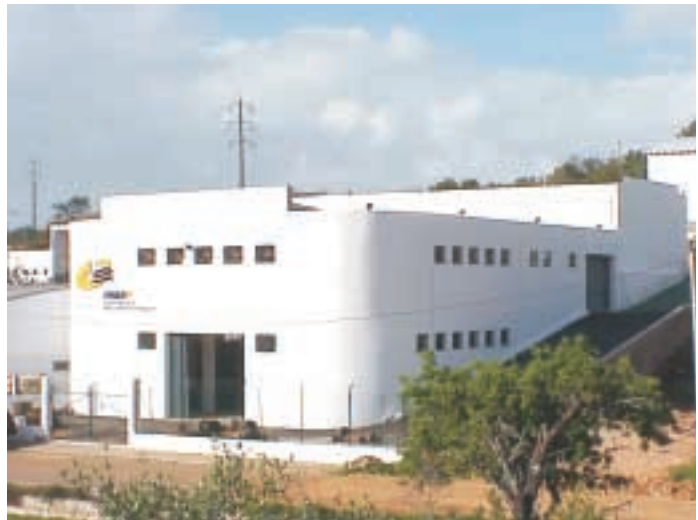
Novo armazém de materiais no Vale da Arrancada
